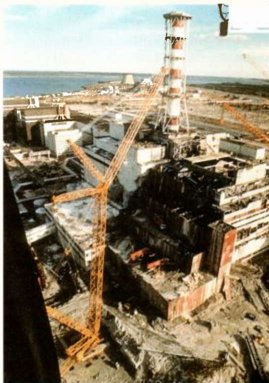
Le site de Tchernobyl Le réacteur 4 au début des travaux de réparation.
