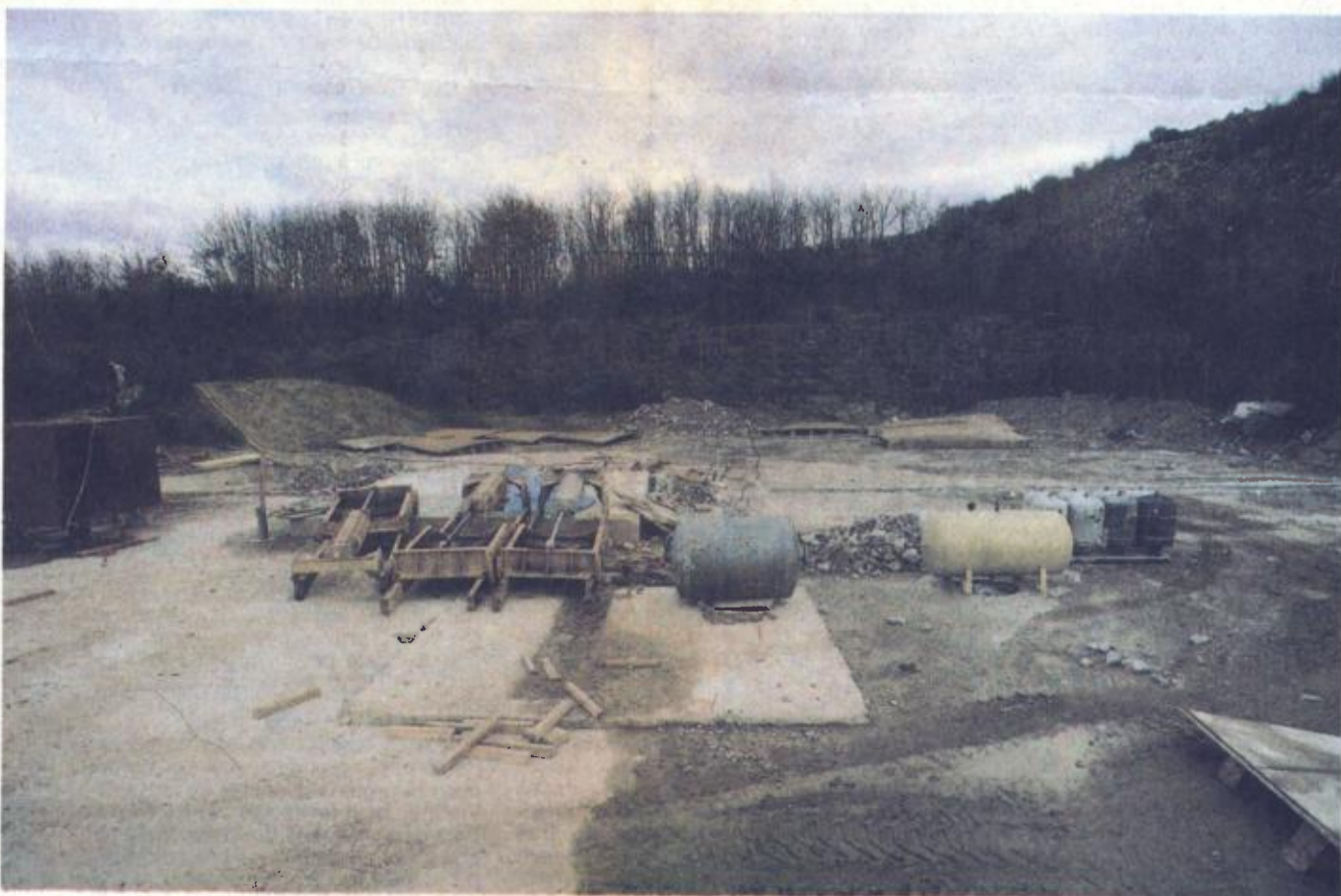
Bellezane : quelques ferrailles et une dalle en béton indiquent l'emplacement du puits.
