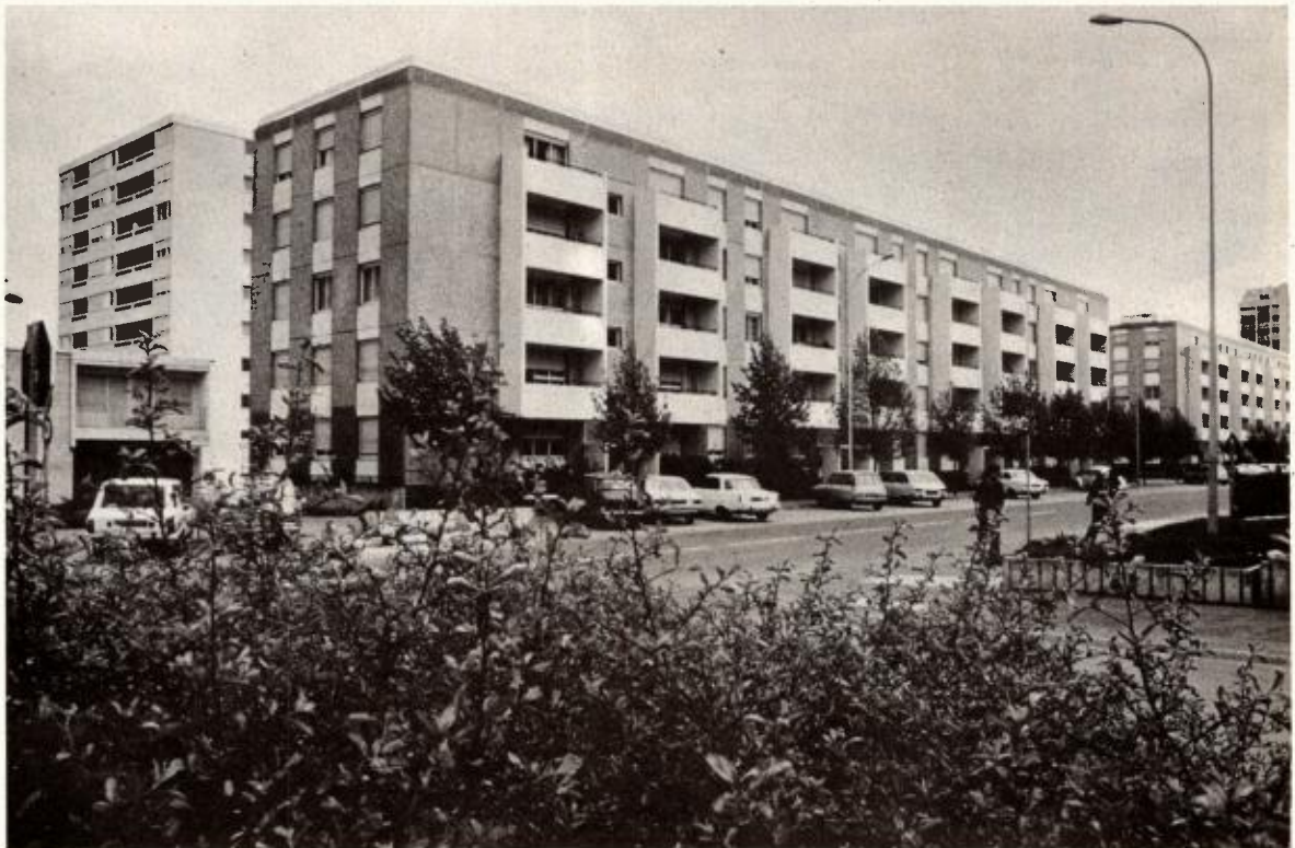
géothermie à la ZUP de Melun.
