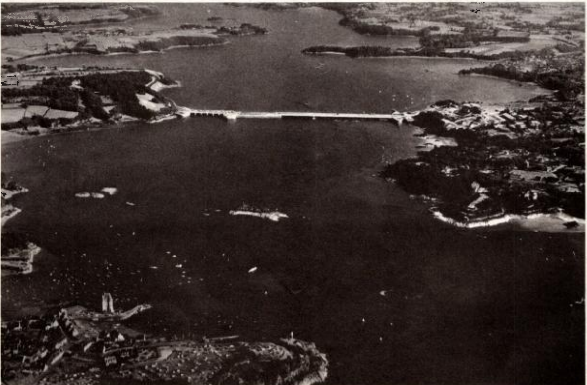
usine marémotrice de la Rance.
