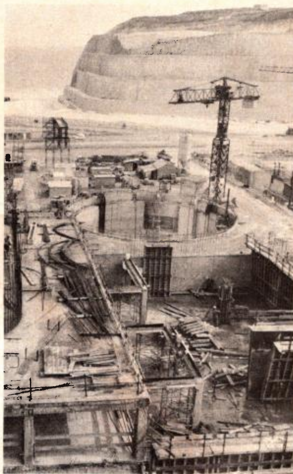
chantier de la centrale de Paluel
