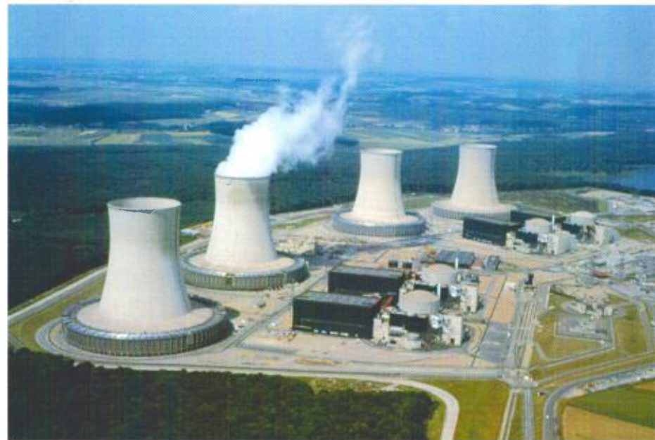
Centrale nucléaire de production d'électricité de Cattenom
