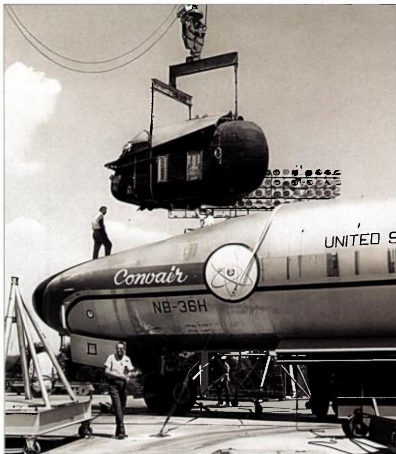
La cuve de protection de l'équipage est installée à bord du NB-36H qui transporte en soute un réacteur nucléaire actif.
