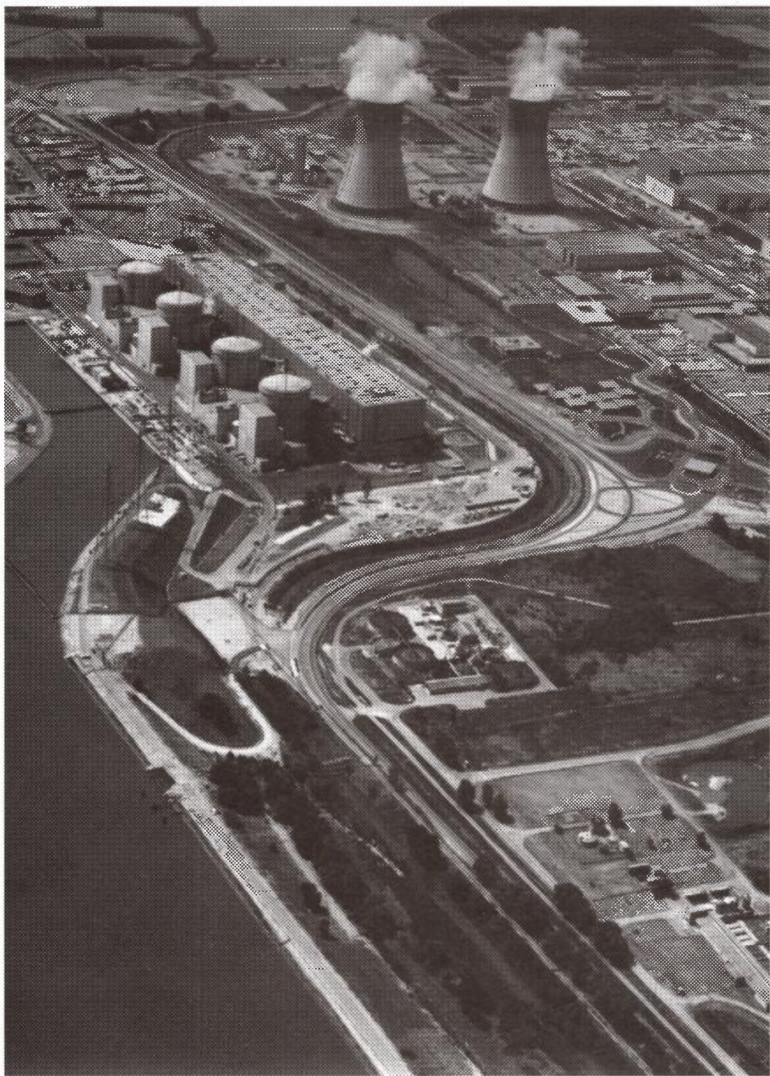
Centrale nucléaire de Tricastin
